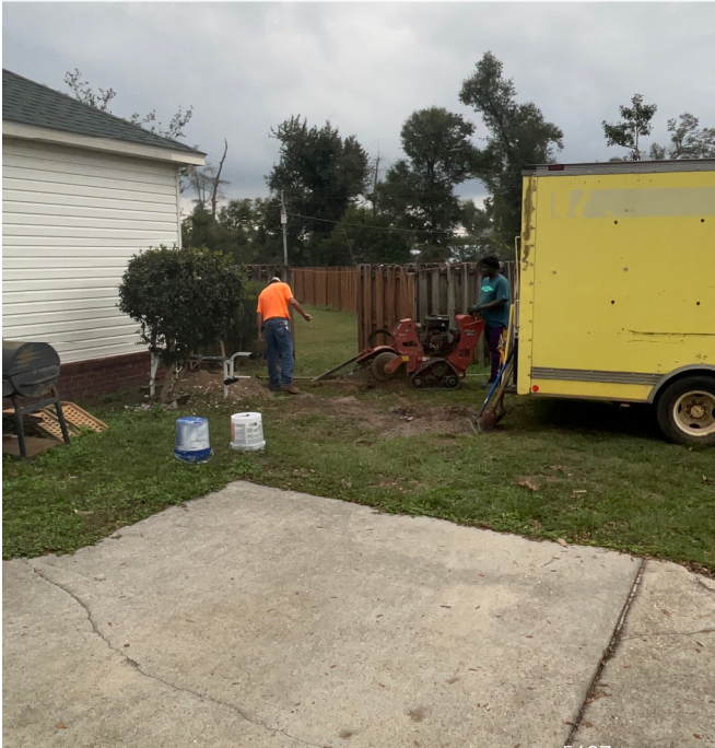
Trenching for conduit
