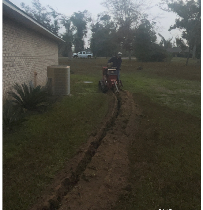
Trenching for conduit
